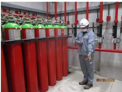
อาคารโรงไฟฟ้า 55 MW : 1st Floor : ห้องเก็บถัง N2 (IG-100)
